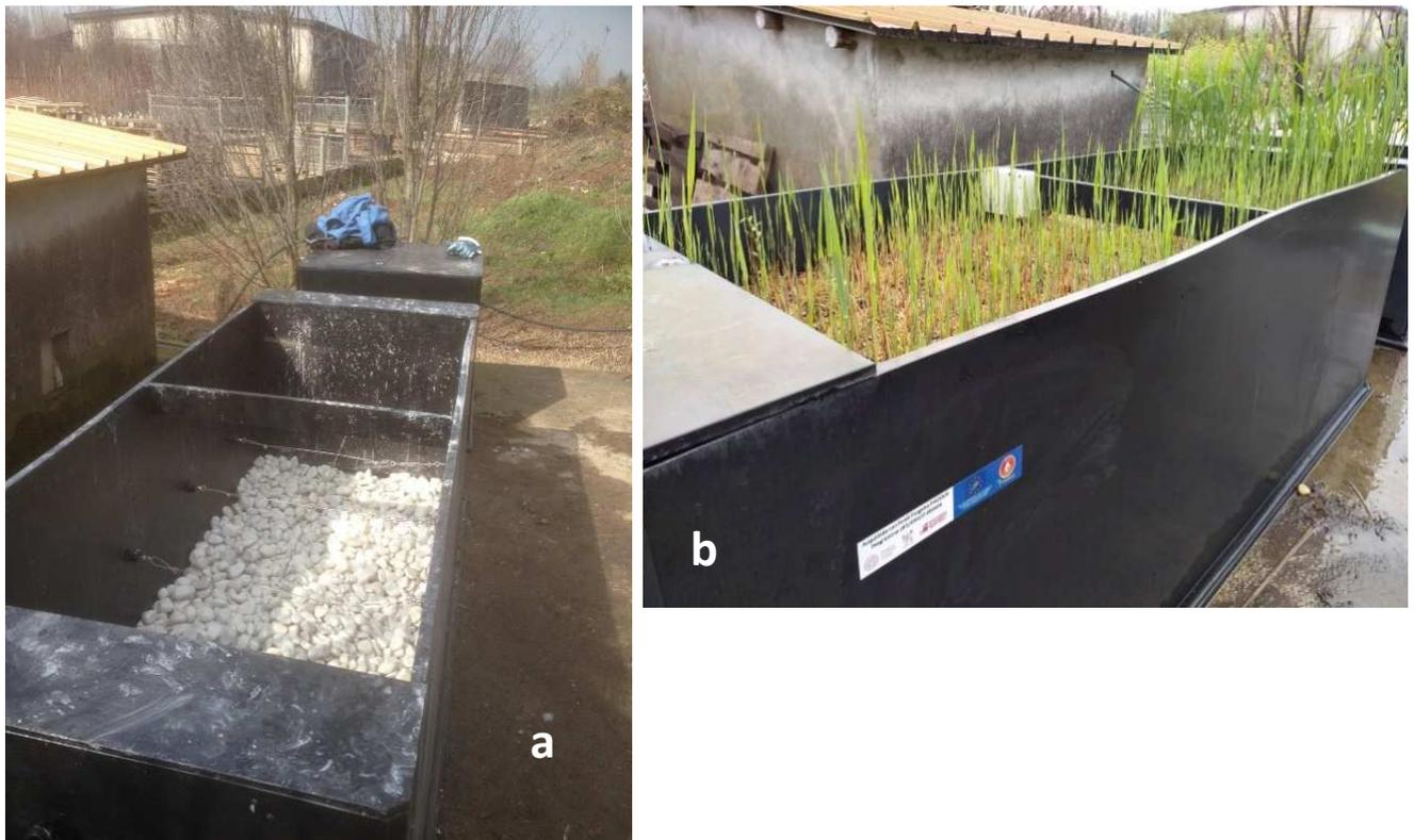
Figura 30. Vasca principale: a) in allestimento con strati di pietrisco sul fondo; b) con giovani piante di *Phragmites australis* piantate da poche settimane
