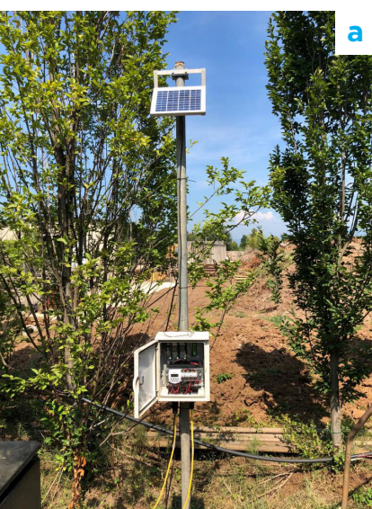
Centralina di controllo delle pompe per l'afflusso di acqua (a). La centralina è alimentata da energia solare (vedi il pannello in alto a sx). Phragmites australis , primavera 2018: b) in aprile, c) in maggio.
